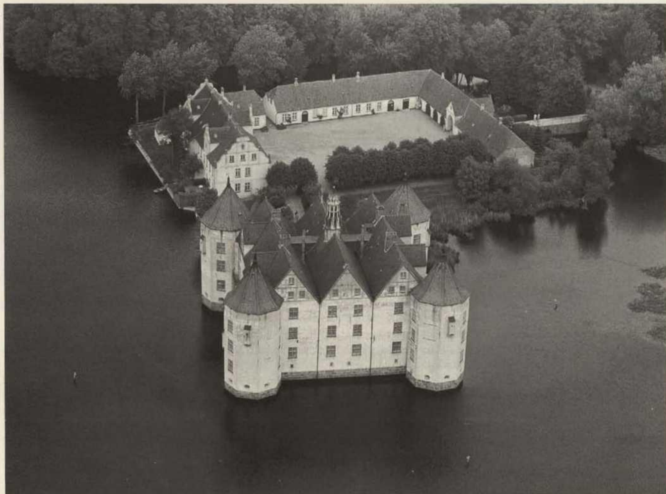
Abb. 6. Glücksburg (Kreis Schleswig-Flensburg), Wasserschloß von 1582/87, französischer Grundrißtypus in landestypischer Ausformung als Dreihaus.
