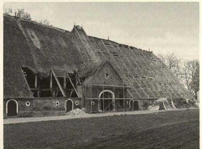
Abb. 17. Die «Konzertscheune» des Gutes Hasselburg während der Erneuerung des riesigen Reetdachs 1979.
