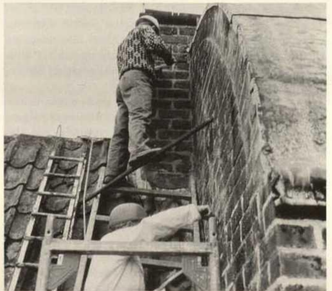
Abb. 36. Hesselagergård, Fünen. Restaurierungsmaßnahmen an einem der ungewöhnlich gestalteten Giebel des Herrenhauses, das nach 1500 von Johan Friis errichtet worden ist.
