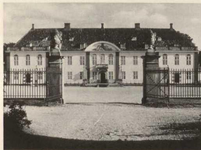
Abb. 28. Ledreborg, Seeland. Das Hauptgebäude wurde nach 1740 für den Premierminister Johan Ludvig Holstein nach Plänen der damals führenden Architekten Krieger, Thurah und Eigtved errichtet. Bedauerlicherweise wurde kürzlich Hausschwammbefall festgestellt.
