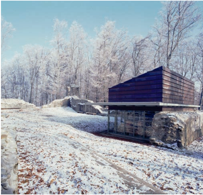
Abb. 8. Melchnau, Burgruine Grünenberg: der moderne Schutzbau über der Kapellenruine mit dem romanischen Fliesenboden.
