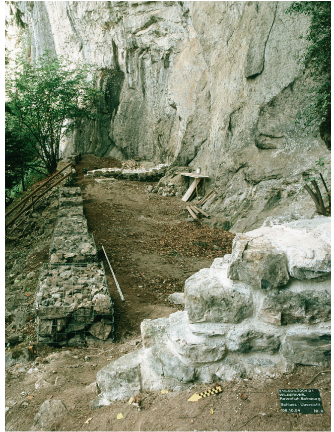
Abb. 7. Wilderswil, Balmburg Rothenfluh: mit Steinkörben markierte und zugleich gesicherte talseitige Fassadenmauer.
