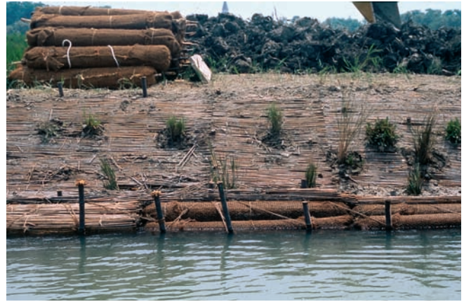
Abb. 4. Venedig, Lagune: Festigung der Barene-Ränder mit natürlichen Methoden.
