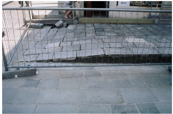
Abb. 6. Venedig, Erhöhung des Niveaus auf Wegen und Plätzen durch INSULA.
