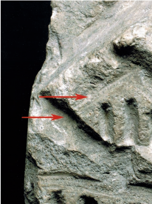
Abb. 6. Hildesheim, ev. Kirche St. Michael, geborgenes Stuckfragment vom Lettner, Detail der Architektur mit sichtbaren Stucklagen an der Bruchkante.
