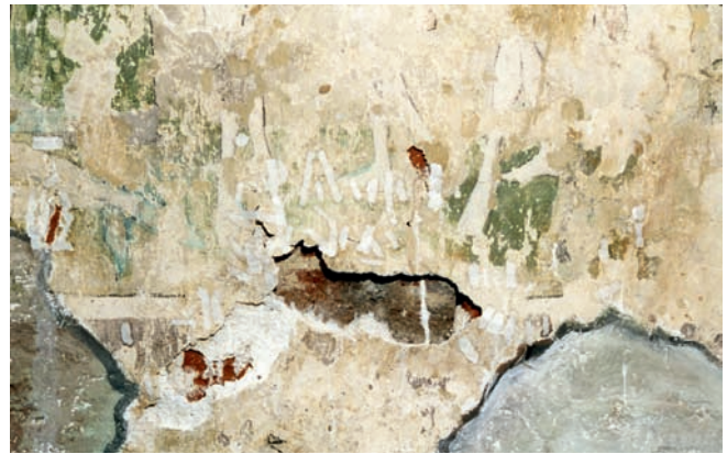
Abb. 4. Lübeck, Aegidienstraße 35, Notsicherung nach Verlust handtellergrößer Malflächen durch Salze.
