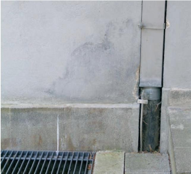
Abb. 3. Dessau, Meisterhaushälfte Muche: Schäden durch Dauerfeuchte im Bereich eines lecken Fallrohrs.
