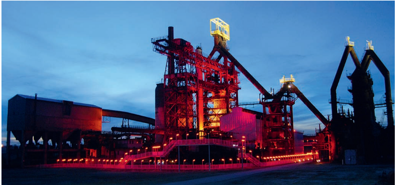
Abb. 1. Uckange (Lothringen, Frankreich), der letzte von ehemals fünf Hochöfen als Lichtinstallation « Tous les Soleils ».
