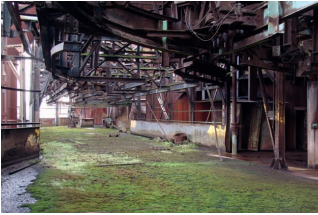
Abb. 6. Völklingen, Weltkulturerbe Völklinger Hütte, Erhaltungsschicht Ruine: die Gichtbühne (Beschickungsebene der Hochöfen) mit starkem Moosbewuchs.
