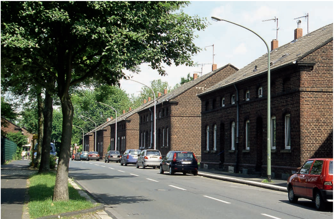
Abb. 7. Essen, Siedlung Meerbruchstraße.
