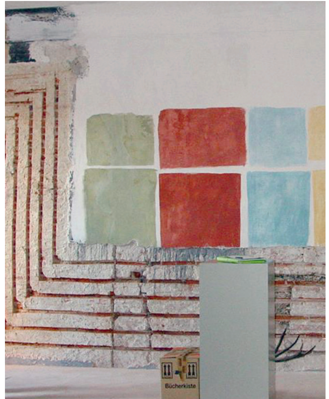
Abb. 5. Landshut, Burg Trausnitz, während der Sanierung, 1. OG, Raum 1: Schlitz für Bauteiltemperierung.
