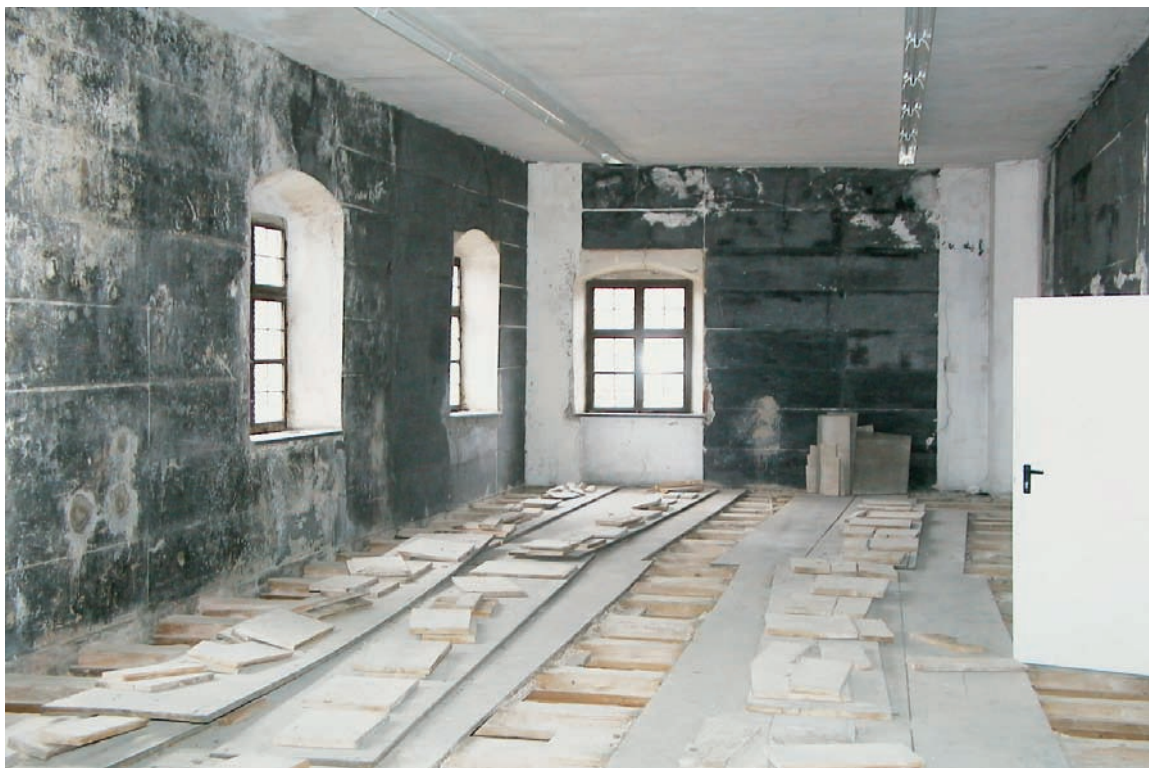
Abb. 2. Landshut, Burg Trausnitz, vor der Sanierung, 2. OG, Raum 4: durchfeuchtete Außenwände.
