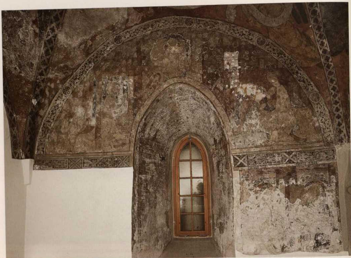
Abb. 138. Masans, reformierte Filialkirche, Chor, Südwestwand im Vorzustand mit einer durch Übermalungen und verbrannte Leimfixierungen farblich entstellten Malerei und Untersuchungsschnitt von 1980 (1996).
