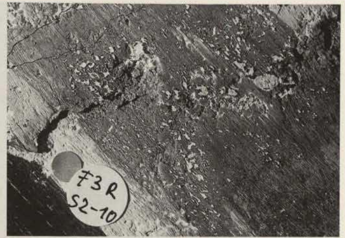
Abb. 130. Sion/Sitten, Notre-Dame-de-Valère, Chor, Schildbogen Südseite, Detail: abrollende Malschicht durch Leimfixierung.
