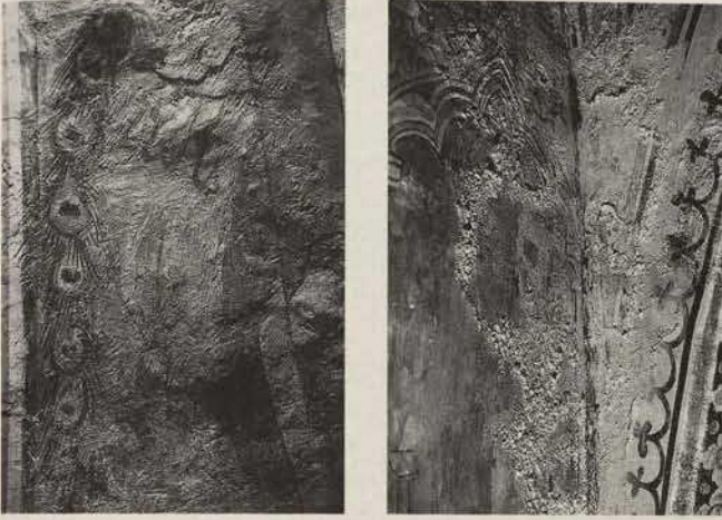
Abb. 128 a-b. Sion/Sitten, Notre-Dame-de-Valère, Chor: Gewölbezwickel mit zerhackter Bildoberfläche und übermaltem Engelsflügel (a), Schildbogen und Gewölbeansatz mit Salzausblühungen und Salzsprengungen auf Gipsputz (b; 1988).
