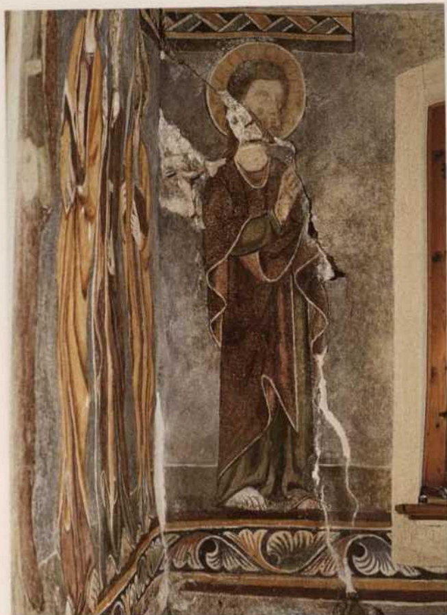
Abb. 141. Lüen, reformierte Pfarrkirche, Südostecke des Saalbaus mit statisch bedingter Rissbildung, großen Hohlstellen und entsprechenden Verlusten (Vorzustand).
