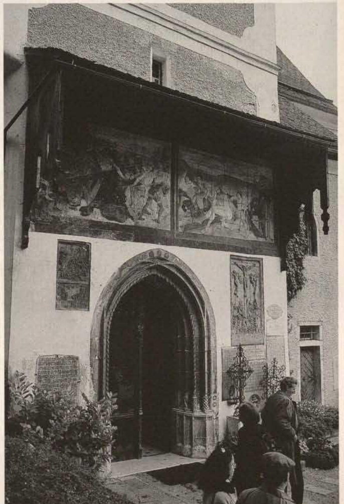
Abb. 149. Hallstatt, Oberösterreich, Pfarrkirche Mariae Himmelfahrt, Wandmalereien über dem Eingang mit Schutzdach aus der Zeit um 1900 (Zustand 1996).
