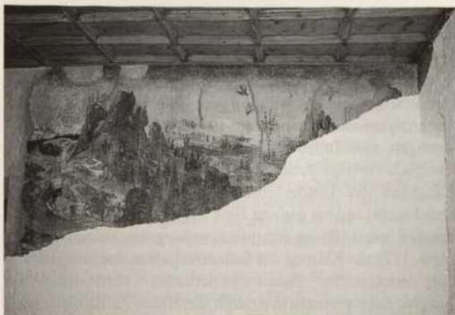
Abb. 152. Volders, Tirol, Schloß Friedberg, Rittersaal, profane Wandmalereien (um 1500), Ausschnitt: Festigung und mehrfache Salzreduktion durch Zellstoffkompressen (1976-1980).
