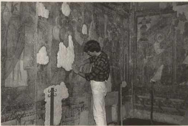
Abb. 172. Lambach, Stiftskirche, ehem. Läuhaus, Nordjoch: periodische Nachsorge mit partiellen Kompressen zur Salz-minderung (1986).
