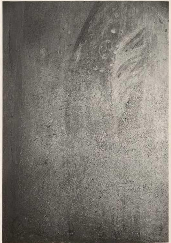
Abb. 166. Salzburg, Nonnberg, Stiftskirche, ehem. Paradies, Westwand, Nische 6, Hl. Gregor, Detail: pulverisierte Malschicht (Zustand 1987).
