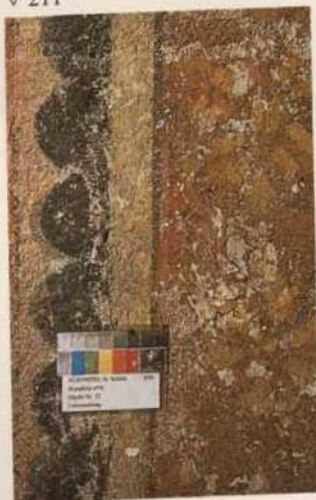
Abb. 210. Nürnberg, St. Sebald, Langhaus, Pfeiler nX, Südseite, Baldachin: Reste einer grünen Erstfassung auf rosafarbener Grundierung, einer roten Zweitfassung und roter Retuschen von 1903/04 (Zustand 1998).
