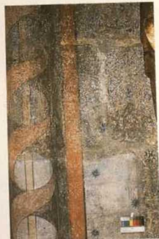
Abb. 210. Nürnberg, St. Sebald, Langhaus, Pfeiler nX, Südseite, Baldachin: Reste einer grünen Erstfassung auf rosafarbener Grundierung, einer roten Zweitfassung und roter Retuschen von 1903/04 (Zustand 1998).
