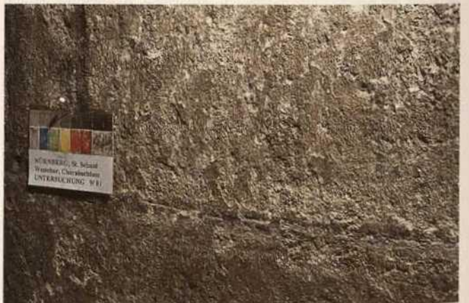
Abb. 218. Nürnberg, St. Sebald, Westchor, Chorabschluss, Reste des bauzeitlichen Fugenbestandes mit Fugenschnitt und schwarzer Linierung (Zustand 2001).
