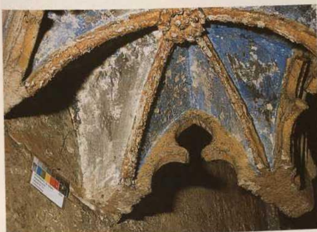
Abb. 206. Nürnberg, St. Sebald, Ostchor, Wandfeld nVII, Baldachin der Sebaldusfigur: Vorzustand mit abblättrender Malschicht, Resten der blau-goldenen Erstfassung und grauen Retuschen der 50er-Jahre (2000).
