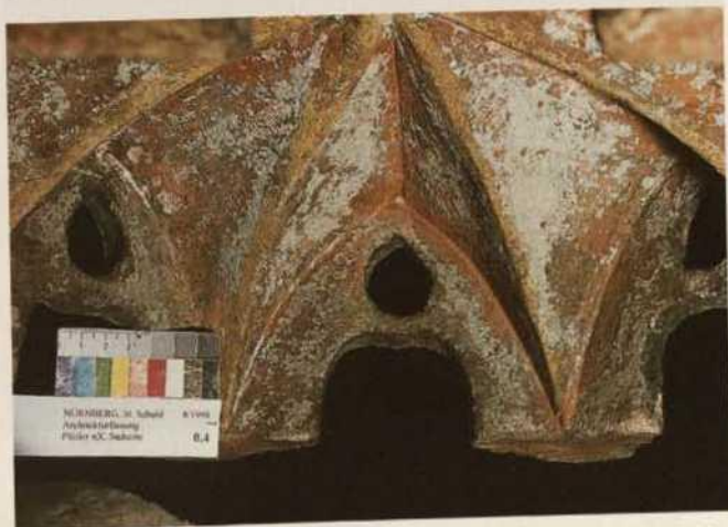
Abb. 210. Nürnberg, St. Sebald, Langhaus, Pfeiler nX, Südseite, Baldachin: Reste einer grünen Erstfassung auf rosafarbener Grundierung, einer roten Zweitfassung und roter Retuschen von 1903/04 (Zustand 1998).
