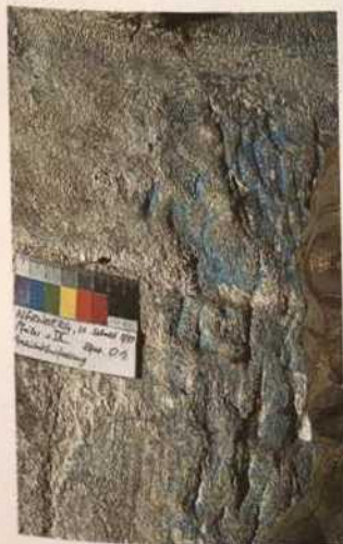
Abb. 206. Nürnberg, St. Sebald, Ostchor, Wandfeld nVII, Baldachin der Sebaldusfigur: Vorzustand mit abblättrender Malschicht, Resten der blau-goldenen Erstfassung und grauen Retuschen der 50er-Jahre (2000).
