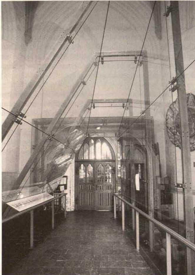
Abb. 238. Berlin, Marienkirche, Turmhalle, verglaster Durchgang zur Stabilisierung des Raumklimas als Schutz für den Wandmalereizyklus.
