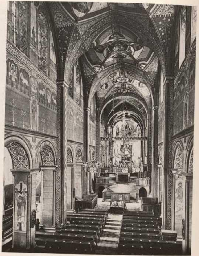
Abb. 259. Braunschweig, Dom, Langhaus nach Osten: Zustand nach der Restaurierung und Neugestaltung durch August von Essenwein, um 1876/81, mit partieller Freilegung und Überarbeitung von Wandmalereien an den Langhauspfeilern und Neufassung der Langhauswände durch Dekorationsmaler Loosen (um 1899).
