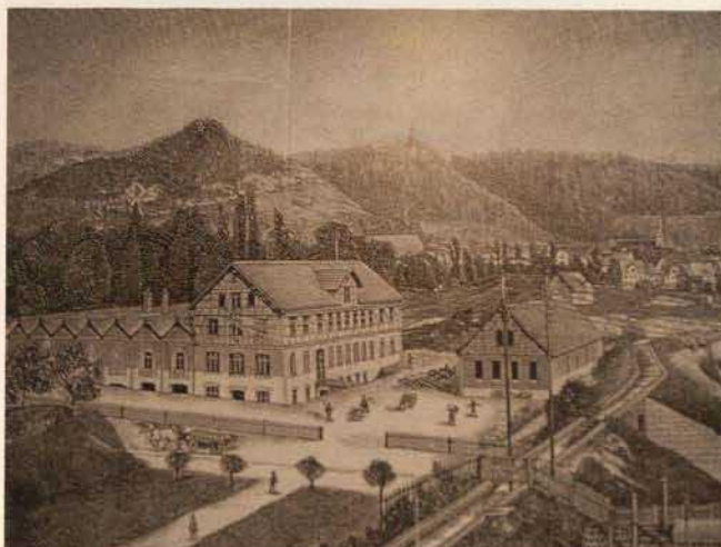
Abb. 5 Werksgebäude Galvanoplastische Abteilung der WMF in Geislingen/Steige, um 1894
