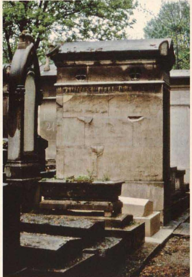
Abb. 18 Cimetière du Montmartre zu Paris: Grufthaus, gefertigt aus dem im Umkreis von Paris anstehenden Kalkstein „Calcaire grossier“. Die geringe Druckfestigkeit dieses porösen Werksteins führte zu Brüchen an den Ecken der Gesteinsblöcke. Ansonsten erwies sich der Kalkstein bei der hier verwendeten guten Qualität als recht verwitterungsresistent: Auch nach einem Jahrhundert der Exposition zeigen sich kaum Korrosionen an der Oberfläche.
