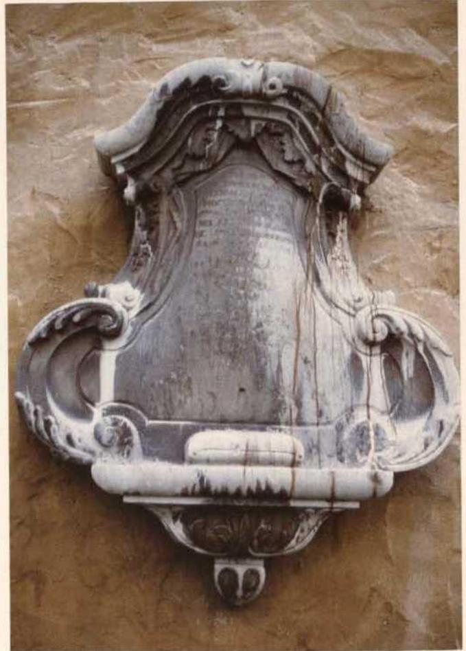
Abb. 27 Kirche des Alten Friedhofs zu Miltenberg/Unterfranken, barockzeitliches Epitaph: Der ehemals schwarze, gelb geaderte Portoro-Oro-Kalkstein aus Portovenere bei La Spezia/Italien ist oberflächlich durch Verwitterung hell gebleicht und nur noch durch die gelben Calcitadern zu diagnostizieren.
