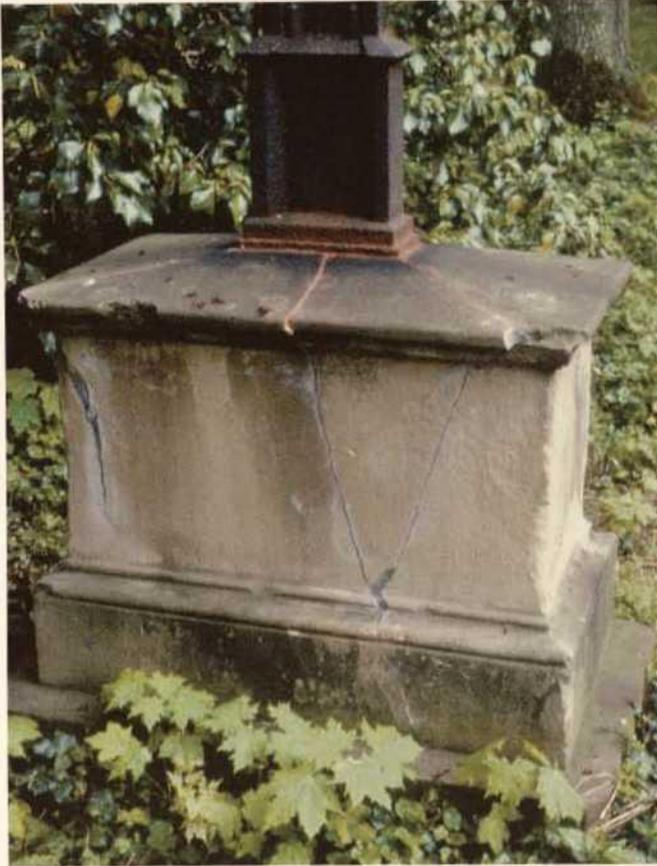
Abb. 21 Ulm, Denkmal auf dem Alten Friedhof: Der in den Kalkstein eingelassene schmiedeeiserne Kreuzschaft hat beim Rosten eine erhebliche Volumenvermehrung erfahren und dadurch den mächtigen Steinblock gesprengt.
