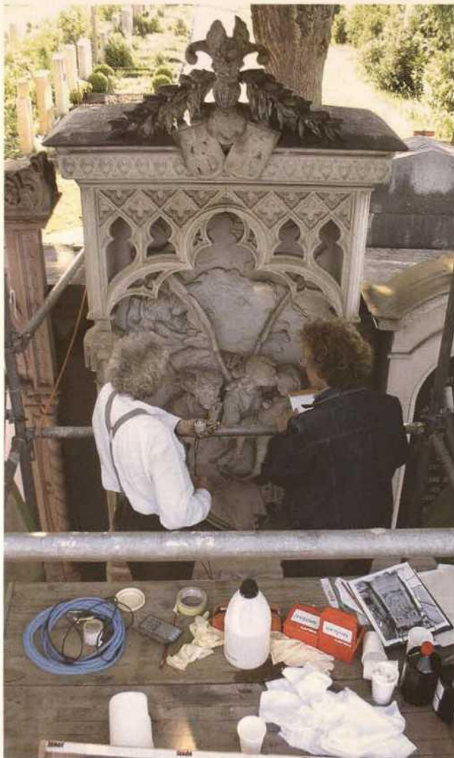
Abb. 11 Grab La Roche, Voruntersuchung mit Festigungsmustern und Ultraschallmessungen
