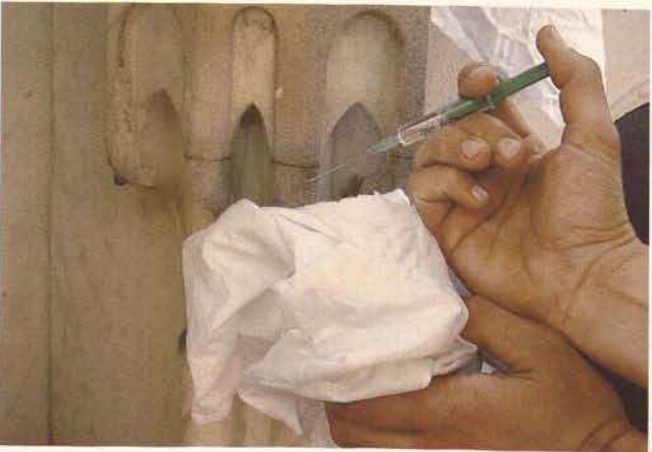
Abb. 7 Grab La Roche, Applikation des Festigungsmittels (Motema Finish)
