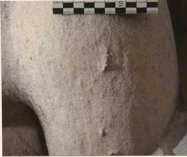
Abb. 10 München, Siegestor, Schulter einer Viktoria (Siegessägtin) mit Rückwitterung der Marmoroberflächen. In der Mitte: ehemalige bildhauerische Oberfläche an großem Einzelkristall sichtbar, der weniger verwitterungsanfällig ist. Gesamtabwitterung von ca. 1–2 mm, somit jährlicher Abtrag von etwa 0,01 mm bei einer Standzeit von 150 Jahren.
