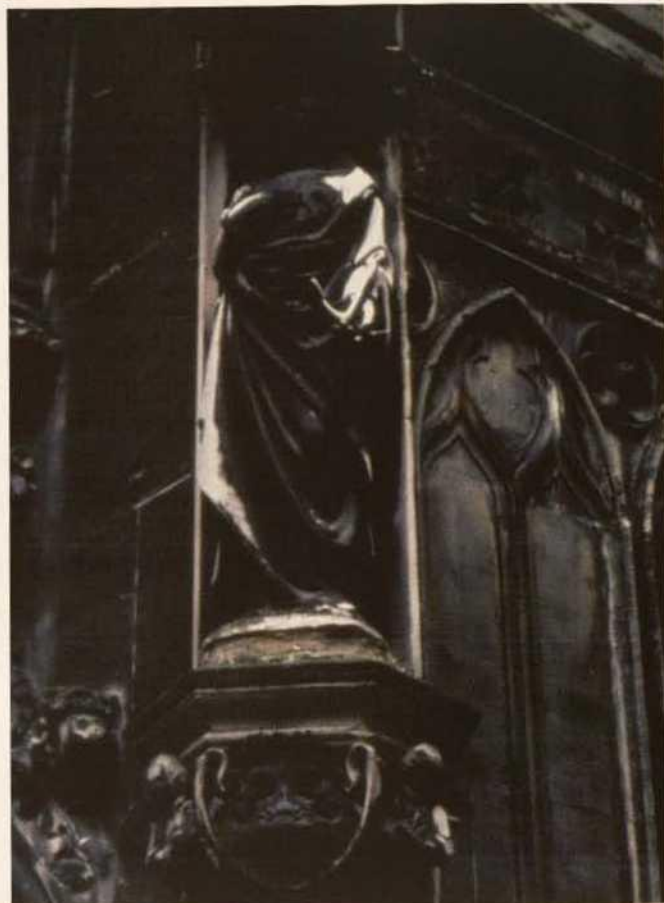
Fig. 7 La chapelle Dubuisson (détail), en 1994, avant restauration: la surface était couverte de croûtes noires (sulfocalcin)
