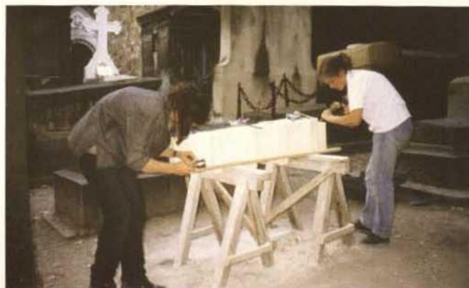
Fig. 6 La chapelle Dubuisson, pendant la restauration en 2005
