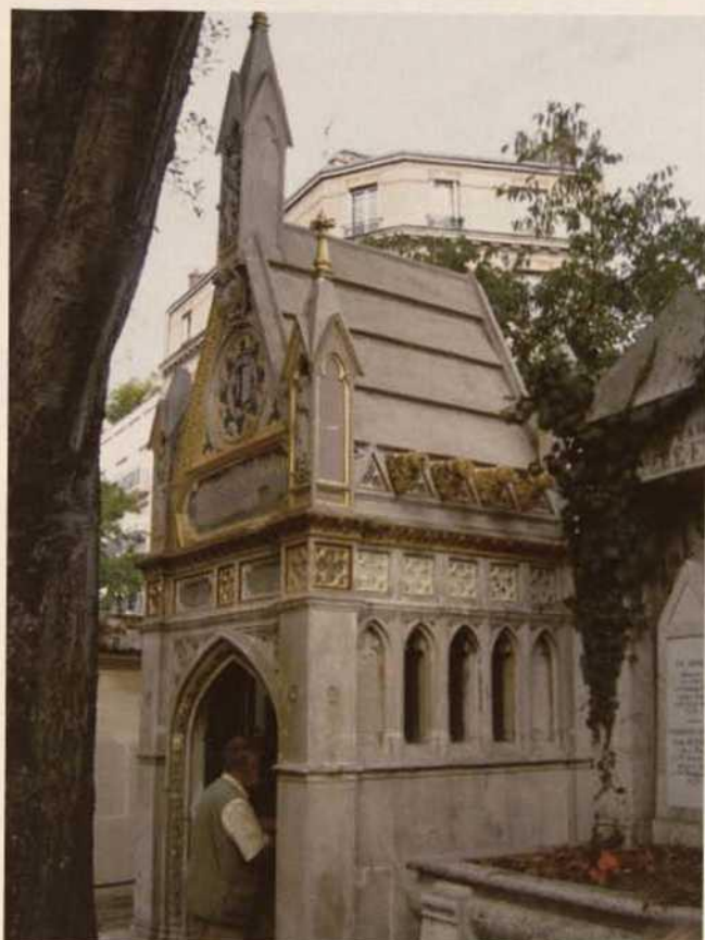
Fig. 2 La chapelle Potocka, en cours de restauration, dorures et polychromies se reconstituent
