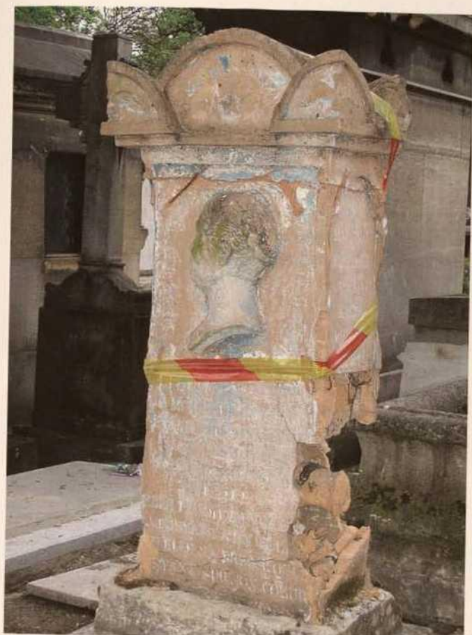
Fig. 8 Tombe Mary, en terre cuite, avant les stages de 2005. De nombreux fragments ont pu être replacés lors du stage
