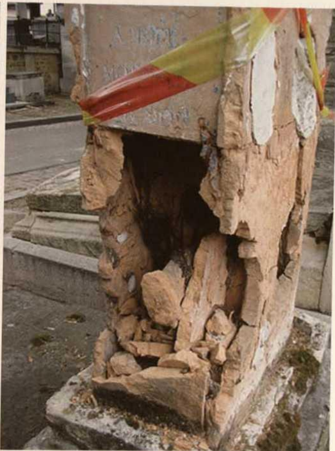
Fig. 8 Tombe Mary, en terre cuite, avant les stages de 2005. De nombreux fragments ont pu être replacés lors du stage
