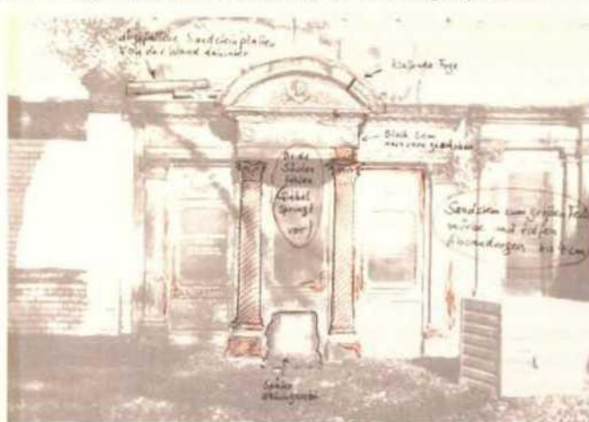
Abb. 1 Bestandsaufnahme als Grundlage der Sicherungsmaßnahmen
