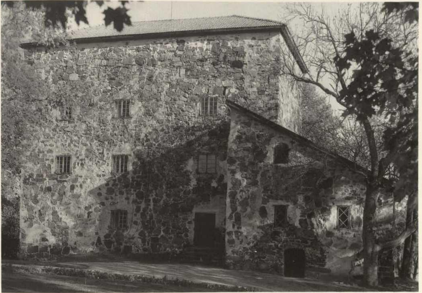
Abb. 52. Das Gut Qwidja bei Åbo, gegen Ende des 15. und in der ersten Hälfte des 16. Jahrhunderts aus Feldsteinen errichtet.
