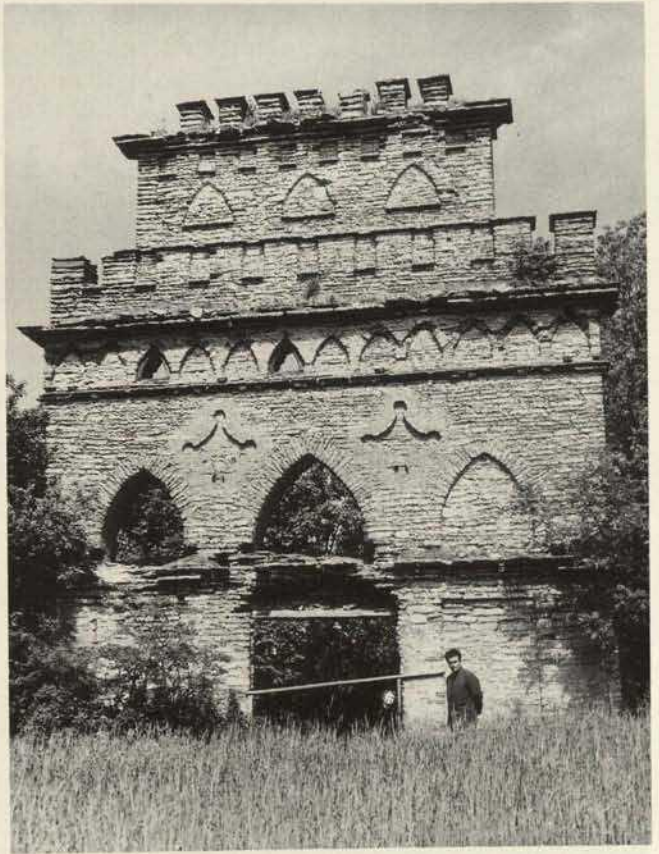
Abb. 59. Kolk, Ruinen des Ochsenstalls.
