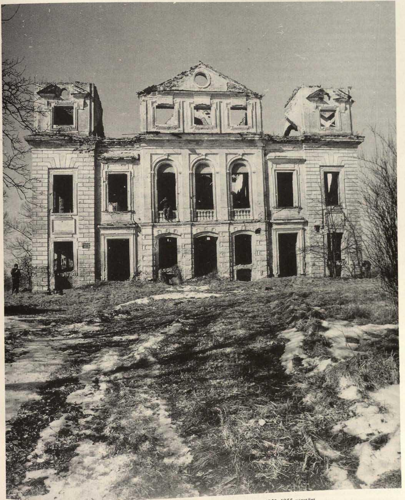
Abb. 75. Zustand des ehem. Schlosses Friedrichslust 1985 (vgl. Abb. 74). Das Schloß wurde 1950-1955 zerstört.
