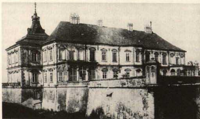
Abb. 80. Podhorce, Palast des Großmarschalls des Königreichs Stanislaus Koniecpolski, 1635-1640, Anlage im Typus «palazzo in fortezza». Der Palast steht auf der Kurtine einer Bastionfestung. Der Grundriß zeigt starken Einfluß französischer Raumlösungen.
