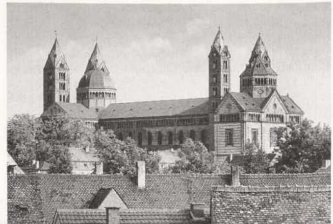
Abb. 19. Dom zu Speyer, Gesamtansicht von Nordwesten (1967).
