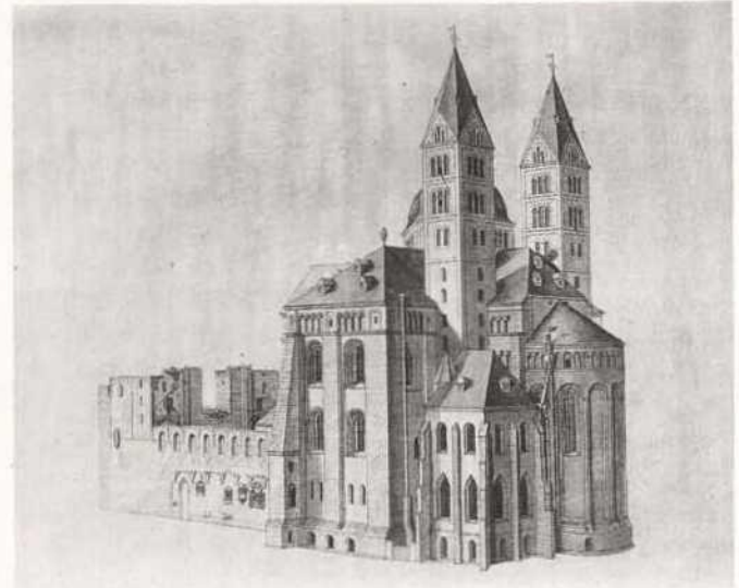
Abb. 18. Dom zu Speyer, Ansicht von Südosten nach 1755. Die Ostteile sind durch Strebepfeiler gesichert, der Westbau (links im Bild) bis zu einer Höhe von wenigen Metern über dem Erdgeschoß abgetragen.
