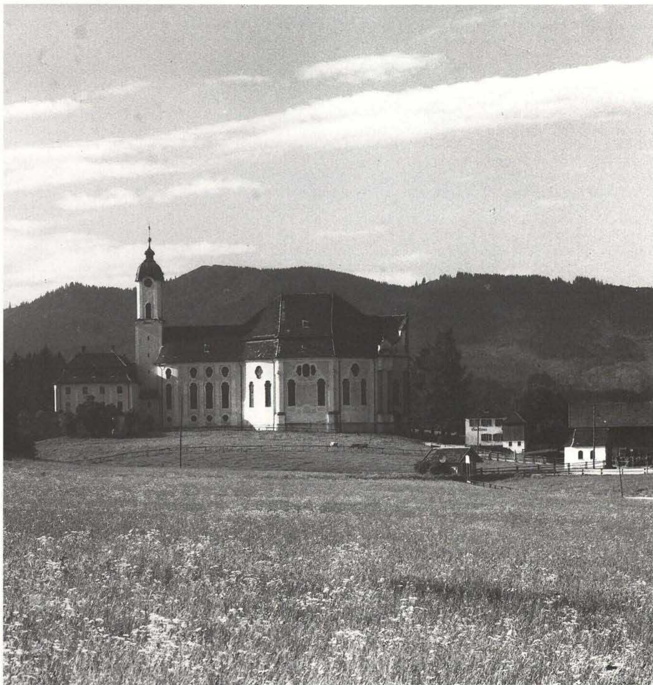
Abb. 29. Wieskirche, Gesamtansicht der Wallfahrtskirche von Norden.
