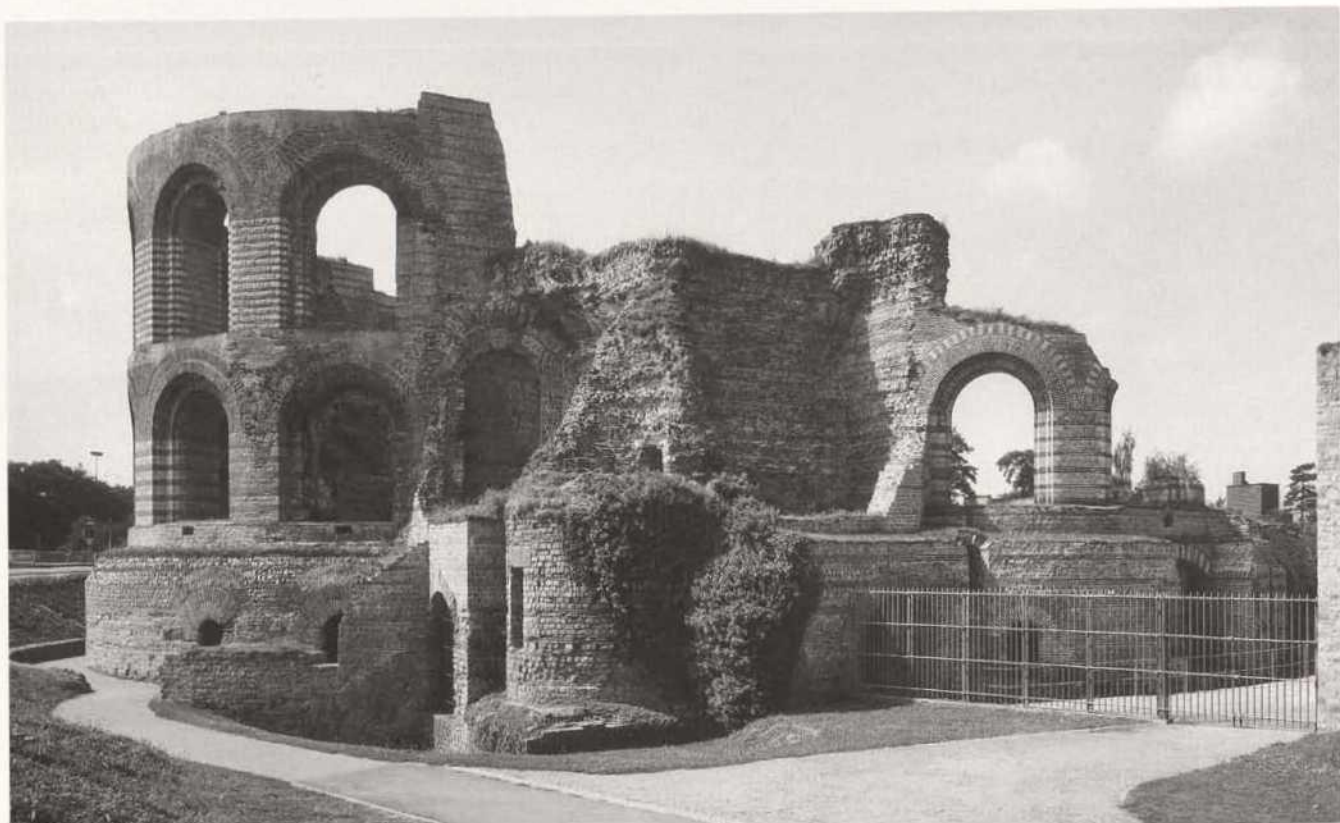
Abb. 55. Trier, Kaiserthermen, Ostkonche des Caldariums nach der Teilrekonstruktion 1983/84.
