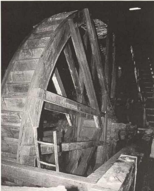
Abb. 125. Goslar, Rammelsberg. In dem weitläufigen untertägigen Roeder-Stollen-System aus dem späten 18. Jahrhundert haben sich von den ehemals vier heute noch zwei in untertägige Radstuben eingebaute Wasserräder erhalten, darunter das sich im Bild befindliche Kunstrad des Serenissimum-Tiefsten-Schachtes.
