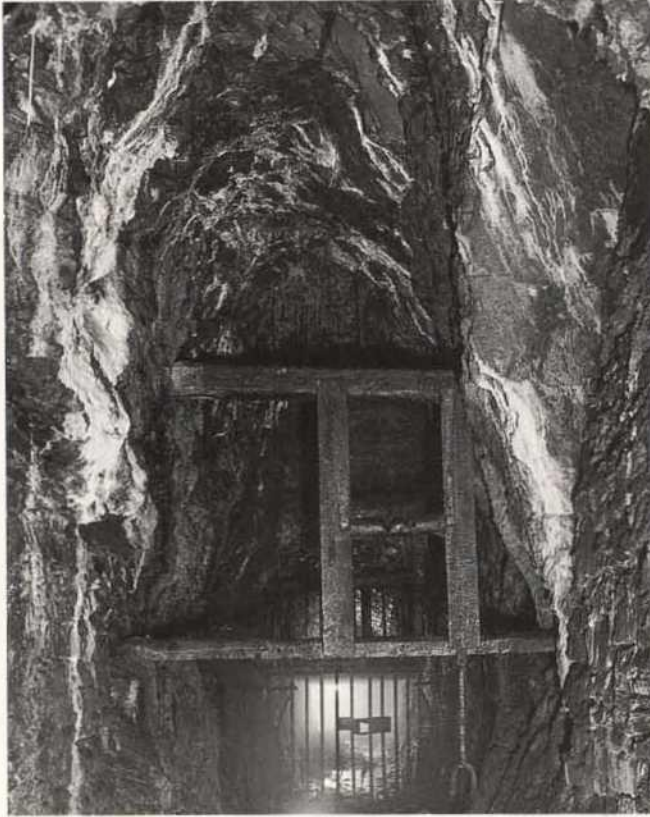
Abb. 124. Blick in die Obere Seilstrecke zum Serenissimum-Tiefsten-Schacht. Im Vordergrund ist eine der erhaltenen Seil- und Gestängeführungen zu erkennen.
