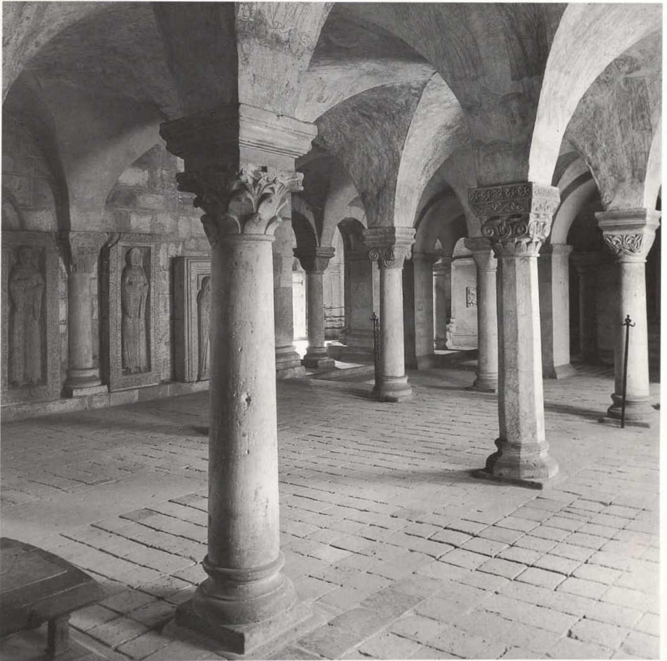
Abb. 131. Quedlinburg, Krypta der Stiftskirche.
