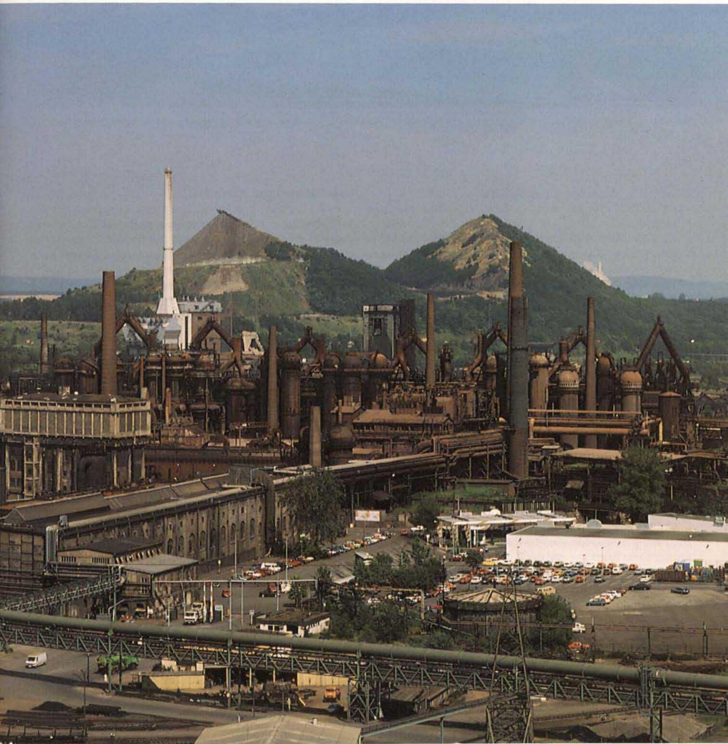
Abb. 133. Völklinger Hütte, Gesamtansicht.
