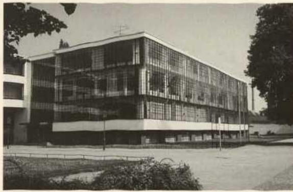
Abb. 9 Dessau, Werkstattheim des Bauhauses, Walter Gropius 1927, rekonstruierte Glasfassade nach Kriegszerstörung
