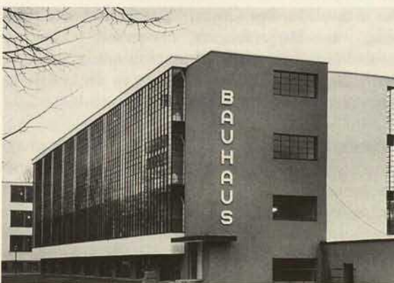
Dessau, Bauhaus, Werkstattflügel, links: Zustand in den 50er Jahren, rechts: Zustand 1976 nach der grundlegenden Wiederherstellung des ursprünglichen Erscheinungsbildes
