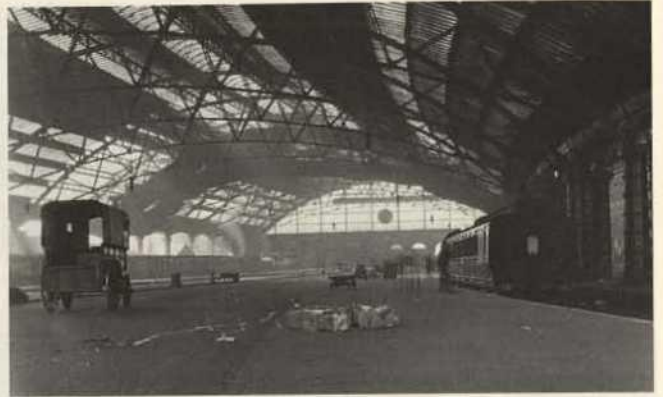
Abb. 3. Liverpool, Bahnhof Lime Street, Gleishalle mit eiserner Dachkonstruktion von 1867 (Zustand 1914).
