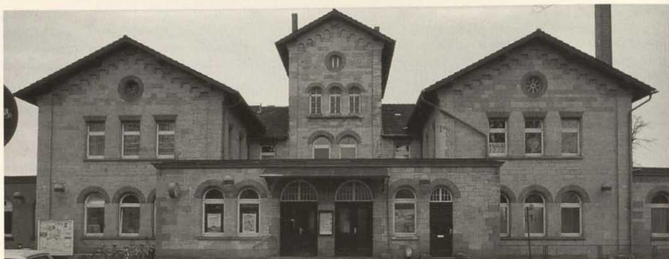
Abb. 17. Bahnhof Wolfenbüttel, Empfangsgebäude, errichtet um 1850 (Zustand 1989).
