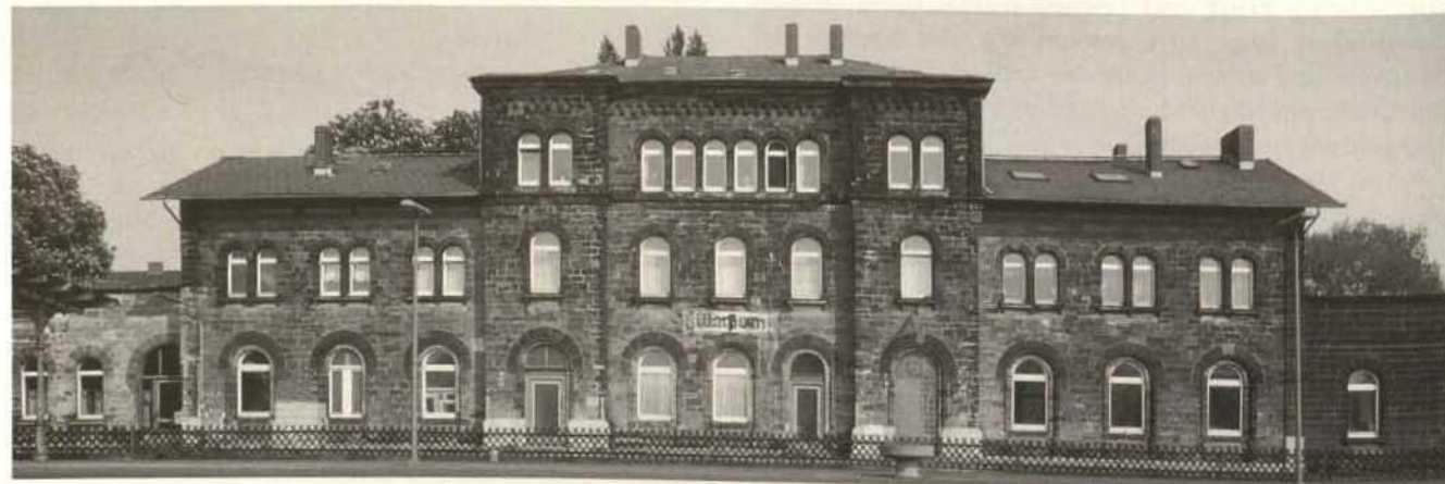
Abb. 18. Bahnhof Börßum, Empfangsgebäude aus den späten fünfziger Jahren des 19. Jahrhunderts (Zustand 1989).
