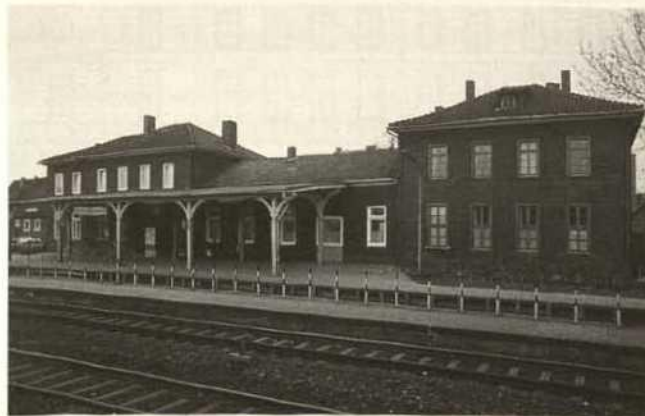
Abb. 13. Bahnhof Schladen, Empfangsgebäude aus den frühen vierziger Jahren des 19. Jahrhunderts (Zustand 1989).
