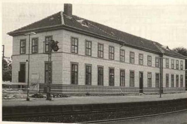
Abb. 14. Bahnhof Vienenburg, ehem. Empfangsgebäude nach Abschluß der Restaurierungsarbeiten (1988).
