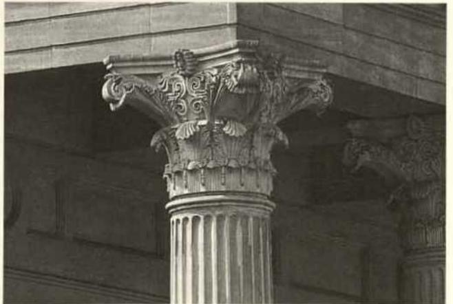
Abb. 58. Bahnhofs- und Direktionsgebäude Elberfeld, Detail vom Mittelrisalit mit in Werkstein nachgebildetem Kapitell.
