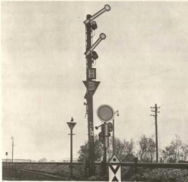
Abb. 81. Zweiflügeliges deutsches Hauptsignal mit Richtungsanzeiger, Geschwindigkeitsanzeiger und dreibegriffigem Vorsignal, 1953.
