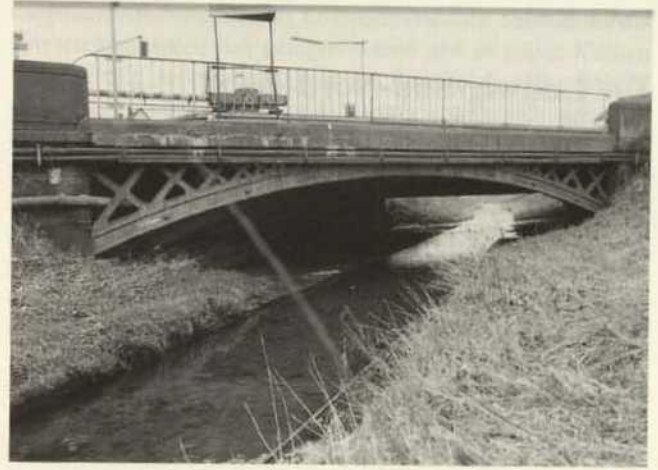
Abb. 102. Gußeiserne Bogenbrücke über den Erlengraben bei Ettlingen, errichtet 1843–45, versetzt 1852.
