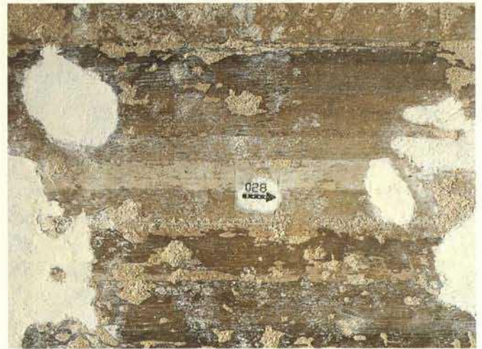
Abb. 34. Lorsch, Torhalle, Obergeschoß, Südwand, Architrav, Detail aus dem östlichen Bereich.
