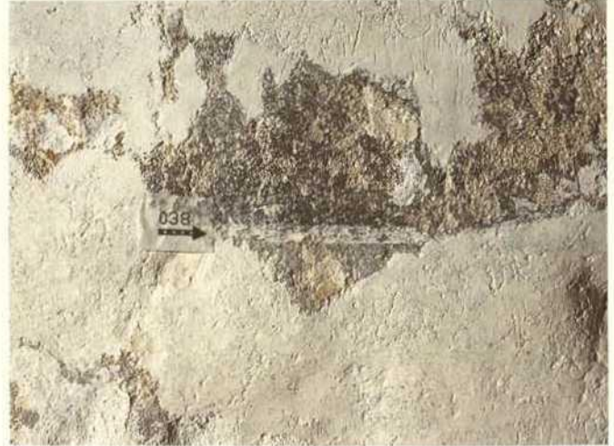
Abb. 28. Lorsch, Torhalle, Obergeschoß, Südwand, Sockelzone: Detail mit Fugenbefund zwischen hell- und dunkelgrauer Quaderung.
