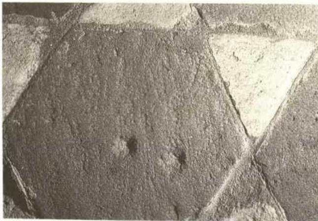
Abb. 12. Lorsch, Torhalle, Ostfassade, Detail der Wandinkrustation mit Bearbeitungsspuren des Zahneisens.
