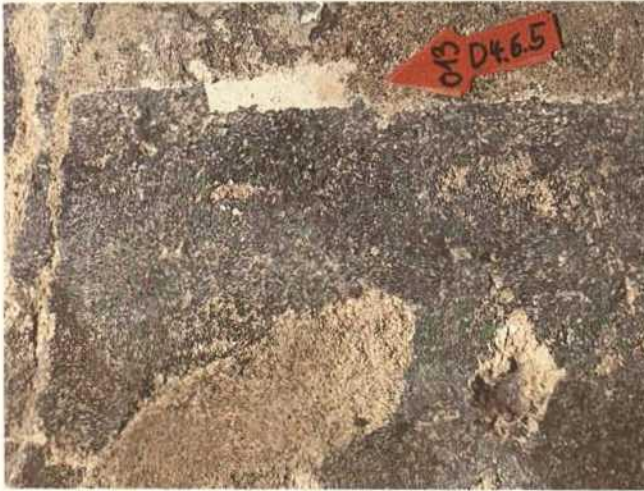
Abb. 25. Lorsch, Torhalle, Obergeschoß, Ostwand, Sockelzone: Detail der dunkelgrauen Quaderung.
