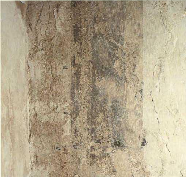
Abb. 30. Lorsch, Torhalle, Obergeschoß, Südwand, Detail des östlichen Säulenschafts.
