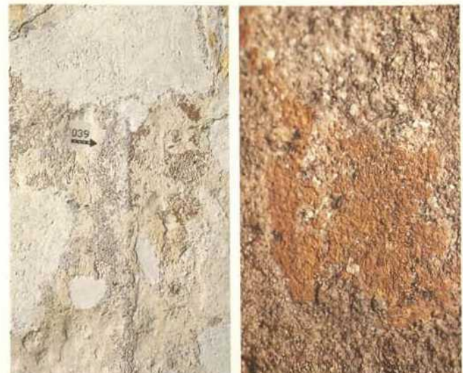
Abb. 29a-b. Lorsch, Torhalle, Obergeschoß, Südwand, Sockelzone: Details mit Fugenbefund zwischen hellgrauer und gelber Quaderung (a) und Farbbefund der gelben Quaderung (b).
