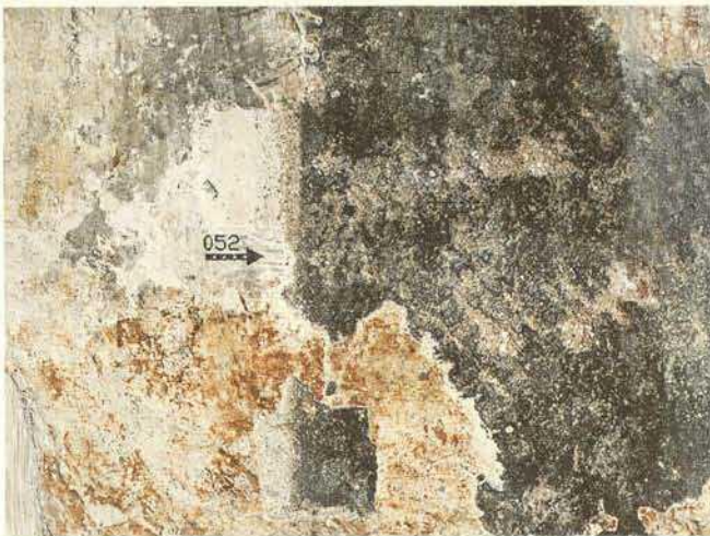
Abb. 31. Lorsch, Torhalle, Obergeschoß, Südwand, Detail des östlichen Säulenschafts mit Anschluß des Flächentons.
