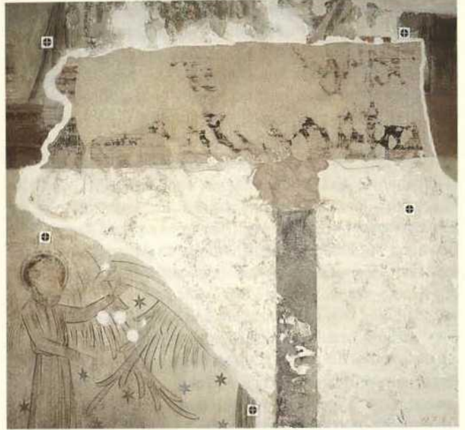
Abb. 27. Lorsch, Torhalle, Obergeschoß, Nordwand, Detail der zweiten Säule von Osten.
