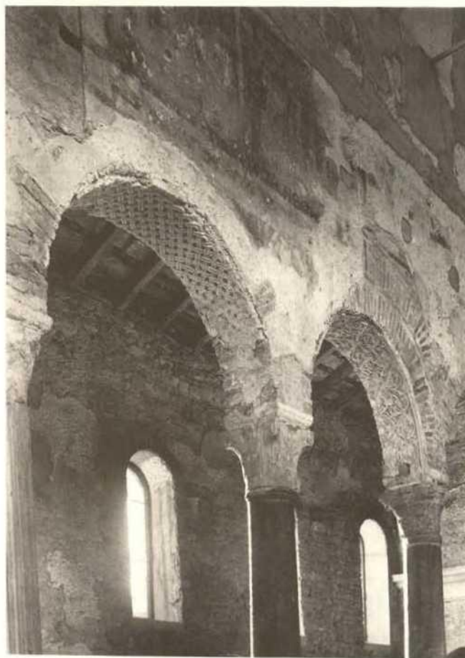
Abb. 46a. Brescia, San Salvatore, Südwand, Arkadenstellung mit stuckierten Bogenlaibungen / parete sud.
