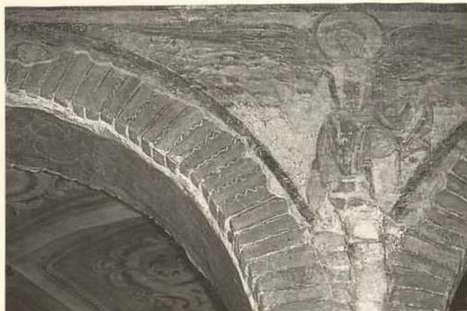
Abb. 182. Acquanegra sul Chiese (Mantova), S. Tommaso, Mittelschiff, Südseite, 2. Arkadenbogen von Westen: Feiner weißer Liniendekor auf rot gestrichenen Keilsteinen und Fugen. Ende 11. Jahrh. (Zustand 1996).
