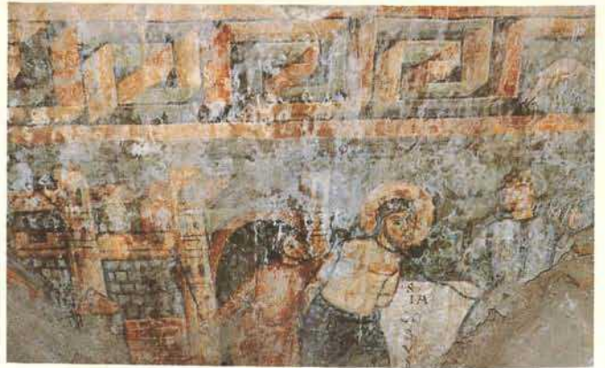
Abb. 199b. Aosta, SS. Pietro e Orso, Dachraum des Mittelschiffs, Südseite, Feld S3. Um 1030 (Zustand 1967).
