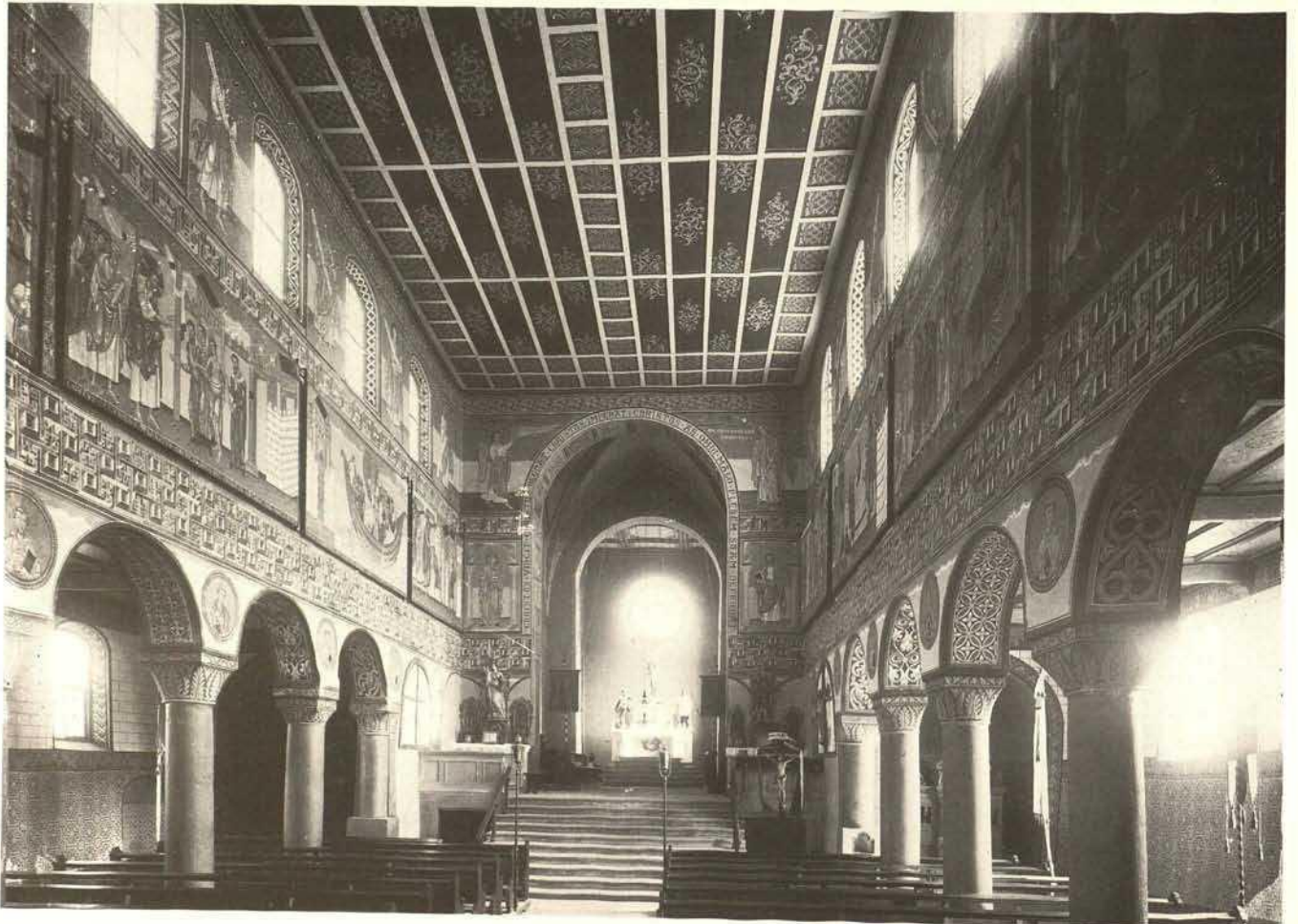
Abb. 237. Reichenau-Oberzell, St. Georg, Langhaus nach Osten nach der Restaurierung durch Schilling (1890-92).
