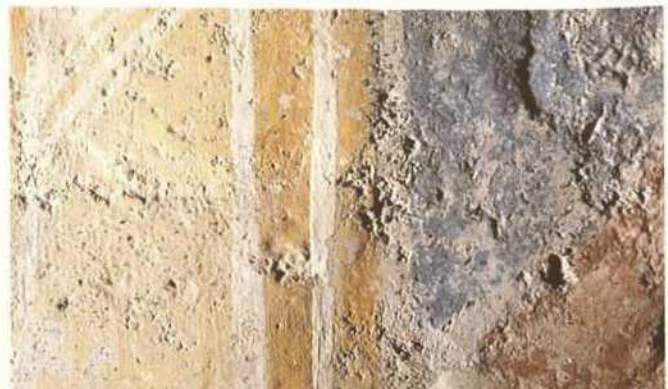
Abb. 251. Reichenau-Oberzell, St. Georg, Nordwand, Detail aus Abb. 253: Die Malschicht liegt auf der Mörteloberfläche, ohne eine Verbindung mit dieser eingegangen zu sein; im Bereich abgeplatzter Malschichten wird die Mörteloberfläche sichtbar.
