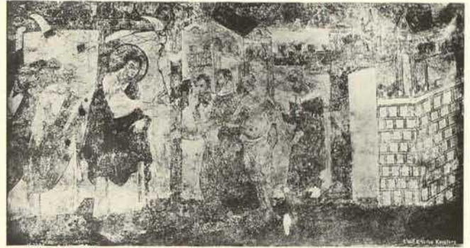
Abb. 238a. Reichenau-Oberzell, St. Georg, Nordwand, Die Heilung eines Wassersüchtigen, nach der Freilegung von 1879-1881.
