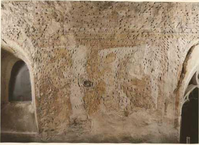
Abb. 273a-b. Goldbach, Sylvesterkapelle, Schiff, Nordwand, Heilung eines Besessenen: angetroffener Zustand (a) mit Hacklöchern der gotischen Phase und Gipskittungen der Restaurierung von 1905 durch Mezger (1990; Streiflicht) und nach der Restaurierung im Auflicht (b; 1995).
