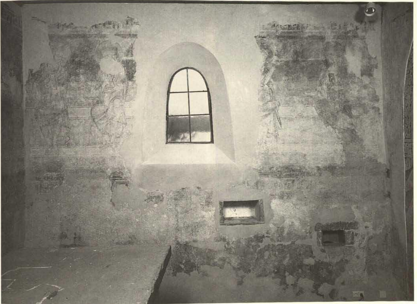
Abb. 297. Goldbach, Sylvesterkapelle, Chor, Südwand. Zustand nach der Restaurierung (1995).
