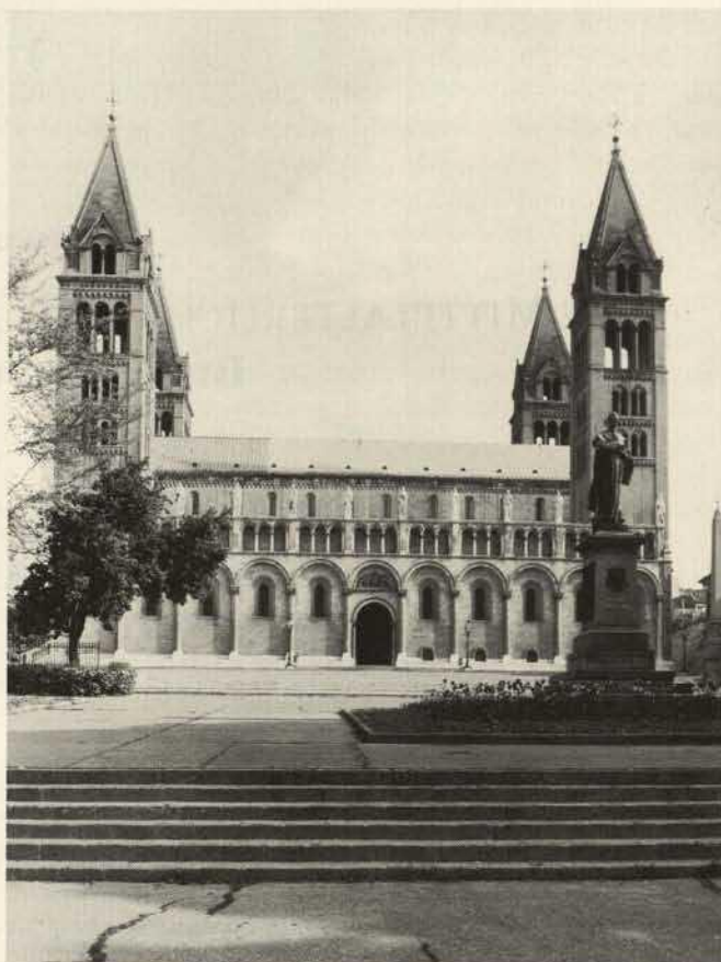
Abb. 7. Gegenwärtiger Zustand des Doms 7. kép. A székesegyház jelenlegi állapota
