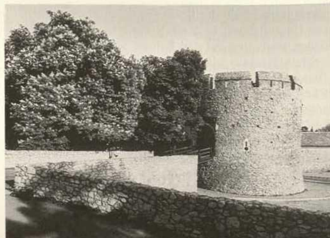
Abb. 55. Ansicht der restaurierten Barbakane 55. kép. A helyreállított barbakan lát képe
