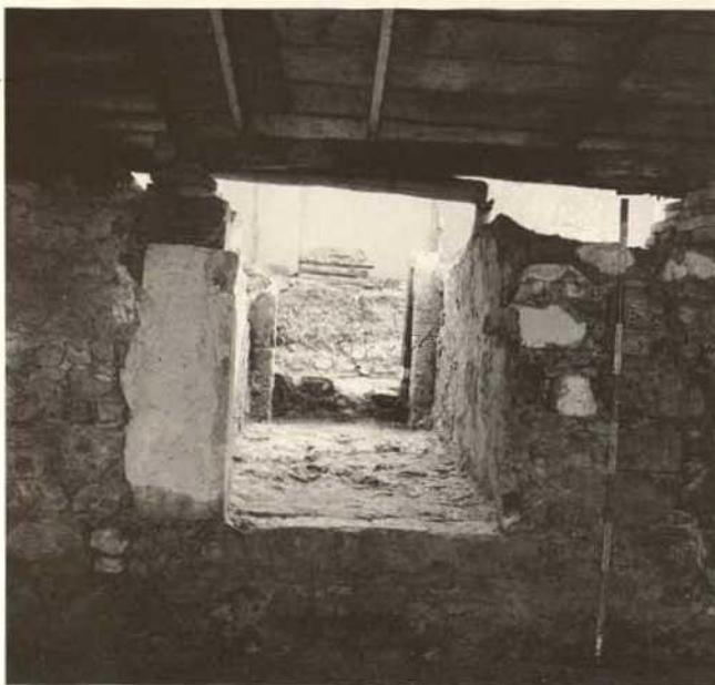
Abb. 170. Durchgang vom Torturm in den angrenzenden östlichen Raum nach der Freilegung der Vermauerung 170. kép. A kaputoronyból nyíló K-i helyiségbe vezető átjáró az elfalazás kibontása után
