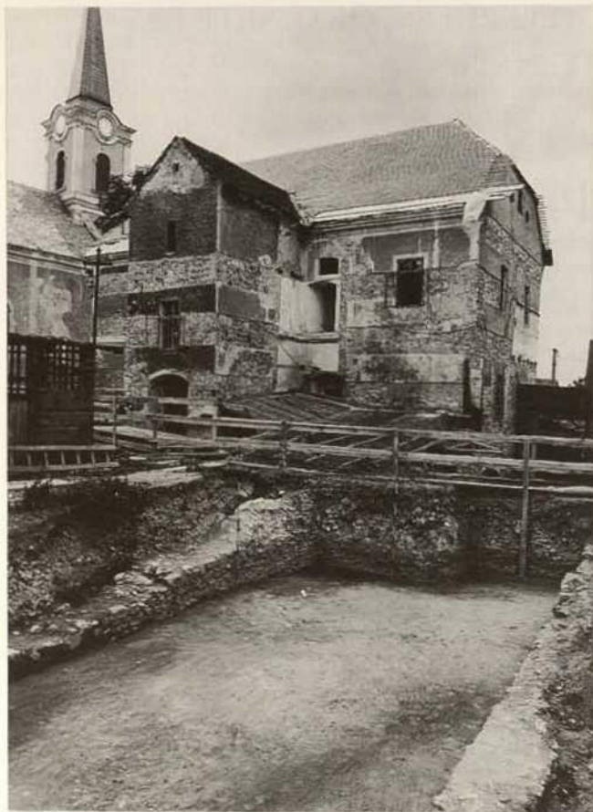
Abb. 132. Ehemaliges Pfarrgebäude während der Freilegung 132. kép. A volt plébániaház épülete feltárás közben
