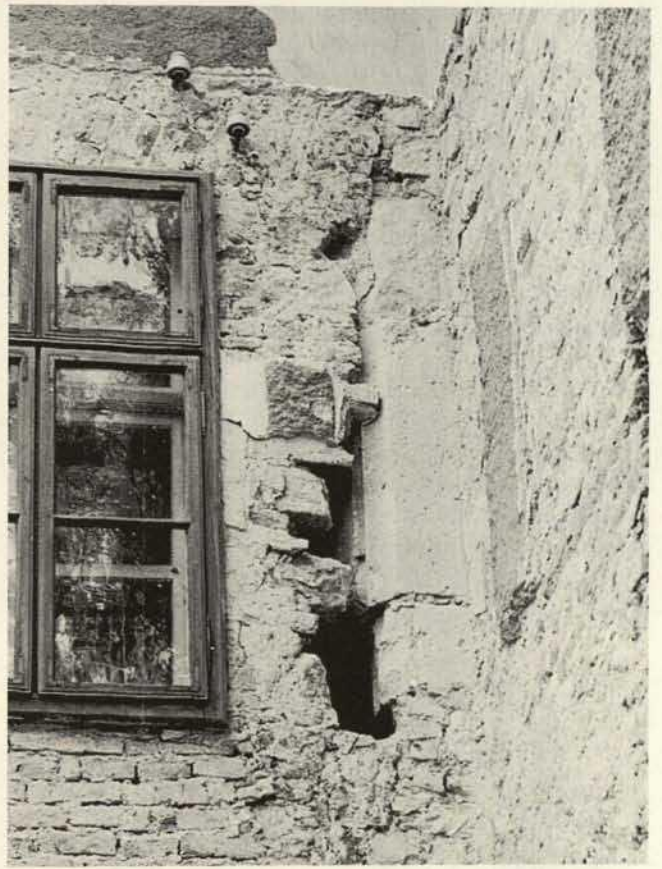
Abb. 138. Stockstein des im Obergeschoß der Ostfassade »in situ« freigelegten gotischen Fensters 138. kép. A K-i homlokzat emeleti szintjén feltárt gótikus ablak „in situ” szárkőve
