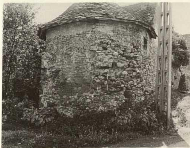
Abb. 168. Detail der türkischen Burgmauer mit dem nordwestlichen Eckturm
