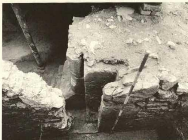
Abb. 173. Östlicher Pfeiler des Südtores mit dem Mauerschlitzz für das Fallgitter und dem Pfannenstein für die Zugbrücke nach der Freilegung
