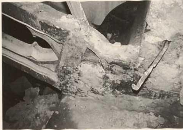
2. Aire-Brücke in Leeds (1827-1829), im Zuge der Sanierung freigelegte Gelenkausbildung im Kämpfer (Foto 1994).
