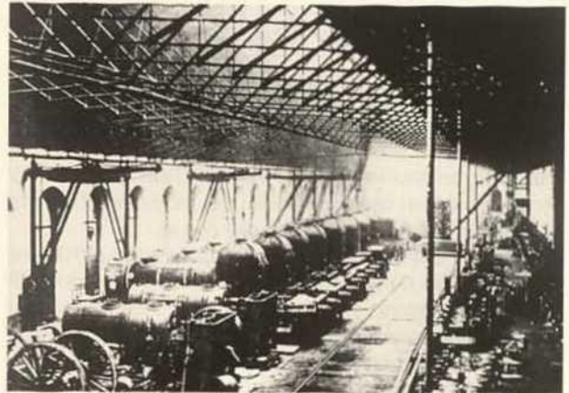
8. Lokomotivmontage in der Eisengießerei und Maschinenbauanstalt August Borsig, Berlin (1844, Erweiterung 1856), Dachtragwerk und Lokomotiven (Aufnahme um 1865).
