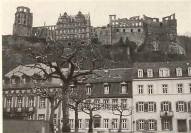
4.-7. Denkmale sehr unterschiedlichen Alters: – Einhardsbasilika bei Steinbach/Odenwald (erste Bauphase 825-827). – Ruine des Heidelberger Schlosses (errichtet im 16. und
