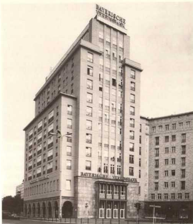
◁ Strausberger Platz, das Haus Berlin und das anschließende Wohnhaus Strausberger Platz 2 nach der Fassadensanierung
